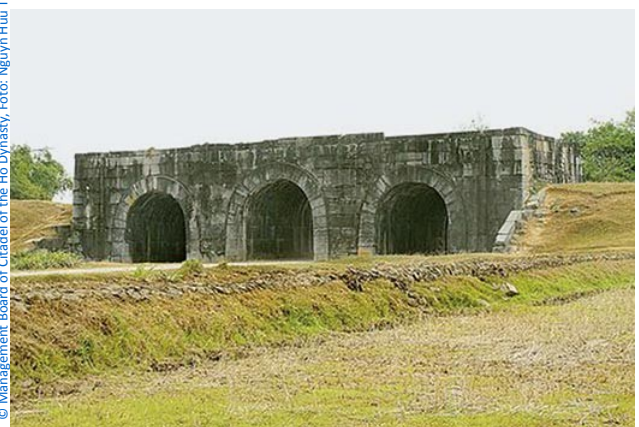
Südliches Tor: Sicht von innen (Südwestachse)
