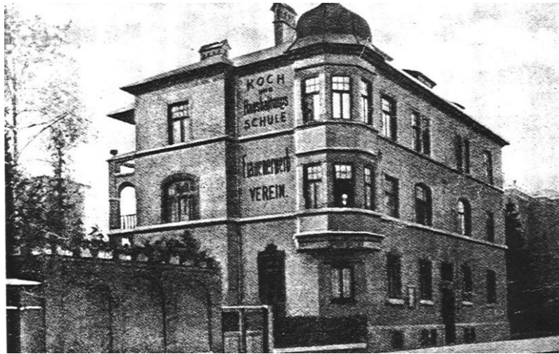
Abbildung 7.1: Am 16. September 1912 wurde die Koch- und Haushaltsschule und das Internat des Frauenerwerb-Vereines in der Ernest Thun-Straße eröffnet.
