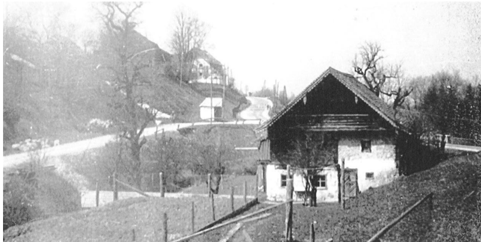
Abbildung 6.1: Das ehemalige Spizkramerhäusl in der Baderluck musste 1958 einem Straßenbauprojekt weichen.
